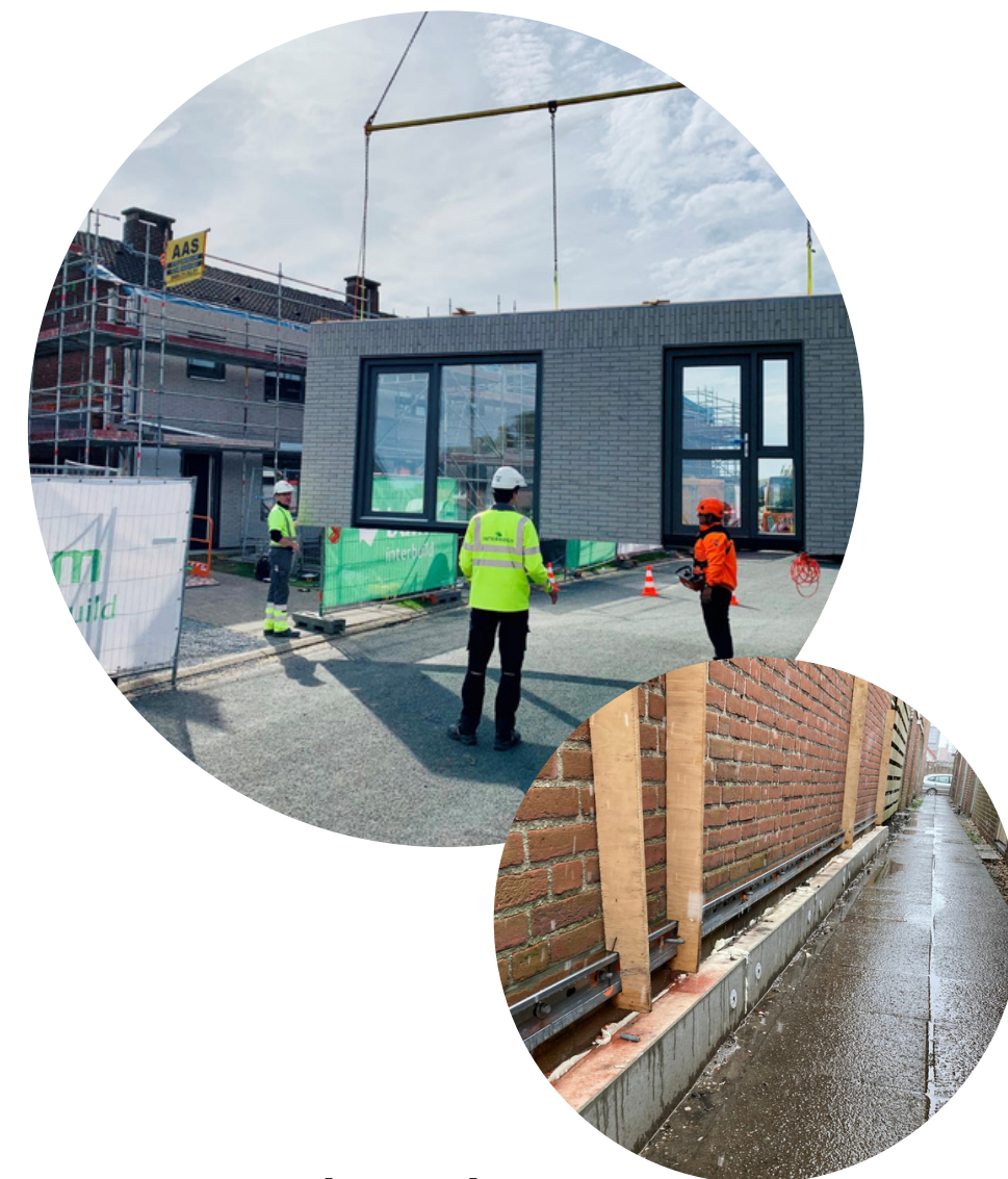
Uitvoering Ankersysteem Gevel, dak, MEP & afwerking
